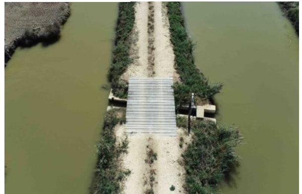
Intégration paysagère d'un ouvrage hydraulique assurant également la continuité piscicole
