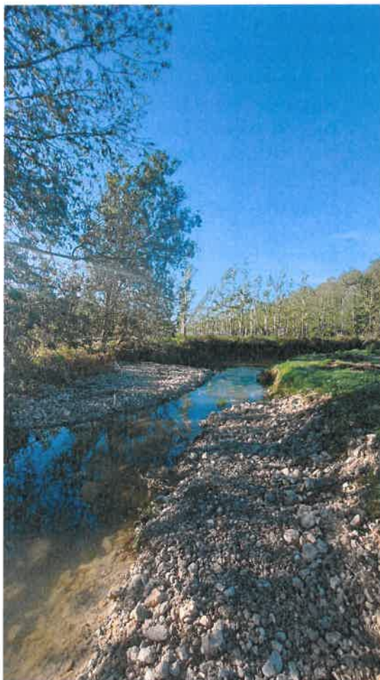
Création d'un lit d'étiage par recharge granulométrique sur le site de Chauvière (Source : SMCA, septembre 2025)
