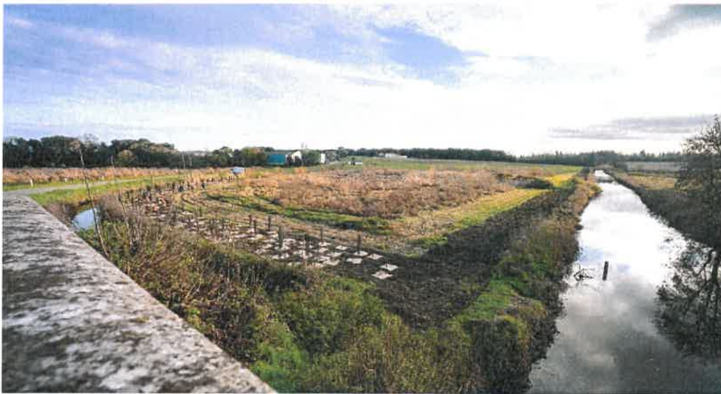
Figure 2: Plantation en cours au bord de l'Arnoult Commune de Trizay
