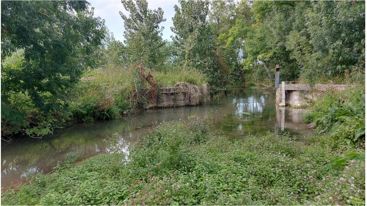
Figure 1: amont du clapet avant travaux (16/09/2024)
