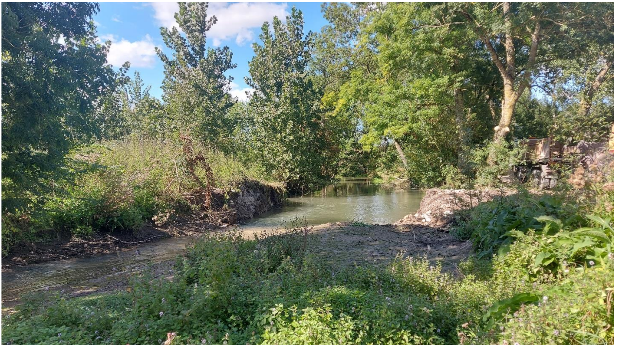
Figure 2: amont du clapet après travaux (19/09/2024)
