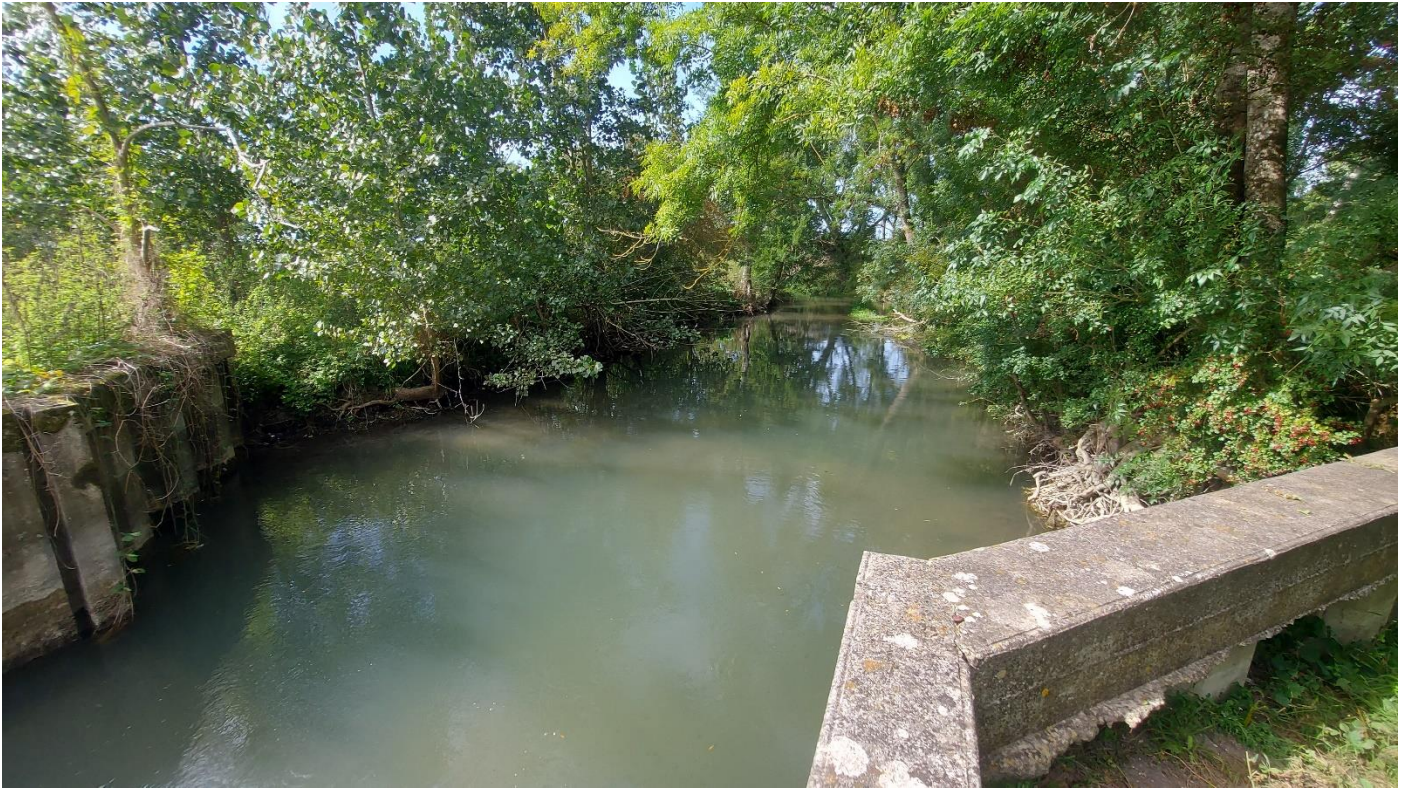
Figure 5: aval du clapet avant travaux
