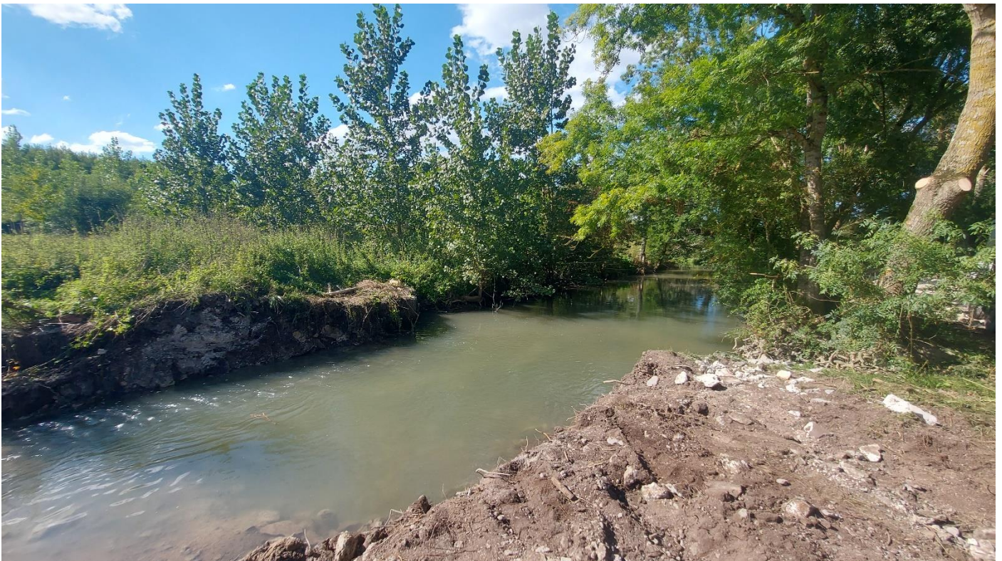
Figure 6: aval du clapet après travaux
