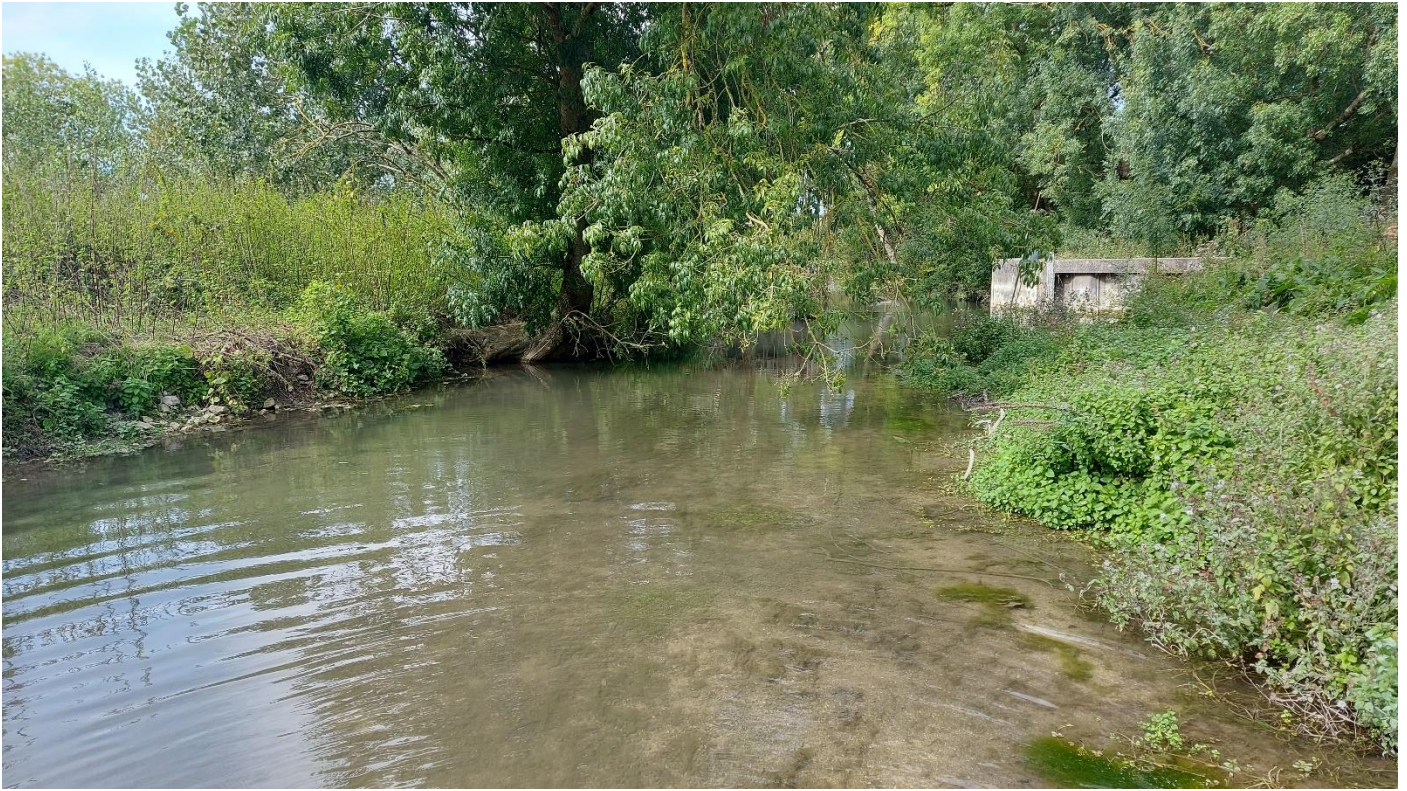
Figure 3: écoulement amont avant travaux (16/09/2024)
